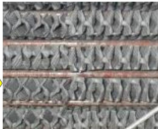
水処理を設置し、薬注、ブローを止め2ヶ月間連続運転。銅管のスケールがかなり剥離
