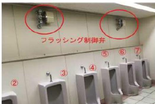
その他節水型トイレの普及により多くの再開発ビルの尿石対策としても採用
